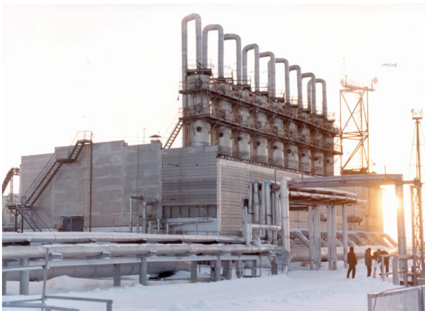
Bild 2: Gasreinigungsanlage in Sibirien
