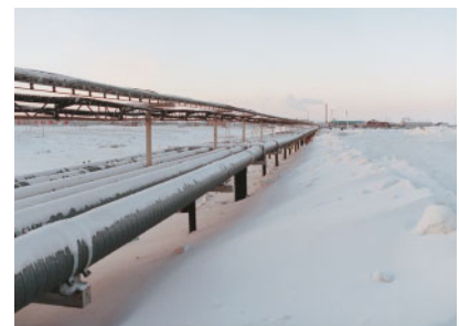
Bild 1: Pipelinetrasse in Sibirien
